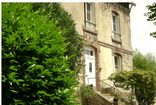
Vue de l'extérieur
