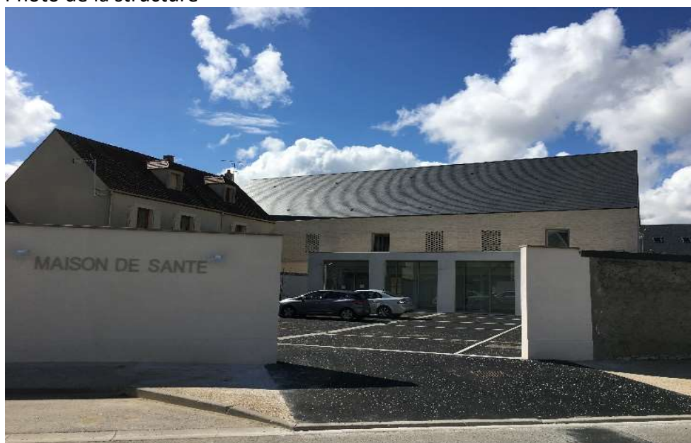
Photo de la structure
