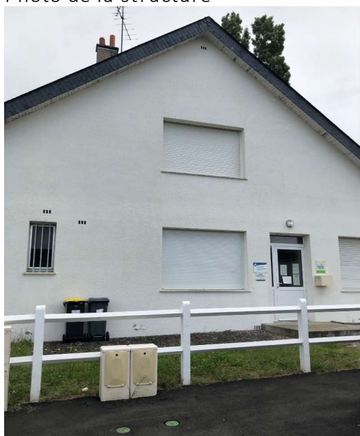
Photo de la structure
